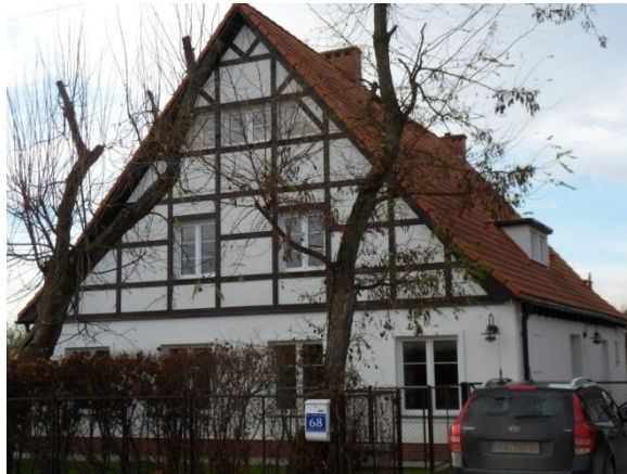
Fot. 4. Zabudowa w konstrukcji ryglowej – mur pruski. Źródło: fotografia własna.
