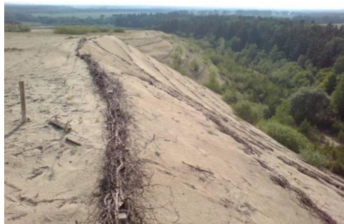
Fot. 3. Umocnienia faszynowe przeciwdziałające erozji, kopalnia Grzybiny, gmina Działdowo. (fot. Mariusz Antolak)
